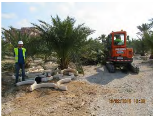
Arranque de palmeras con miniexcavadora giratoria.
