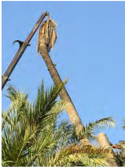
Izq.: Sujeción de carga no estabilizada con grúa autocargante. Dcha: Accidente por desplazamiento de centro de masas en autocargante.
