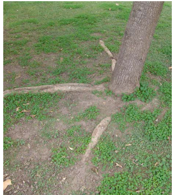
Árboles con defectos de plantación
