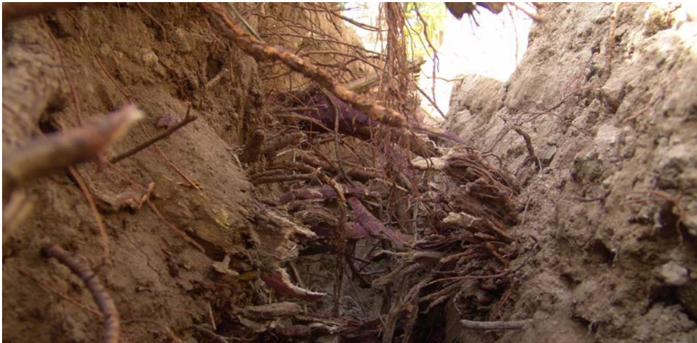
Zanja en la que se han eliminado todas las raíces de un árbol próximo
