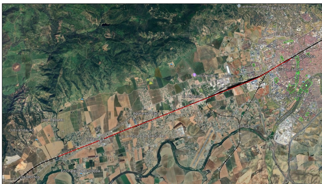
Imagen 7. Detalle por donde discurre el Gran Eje Ferroviario F_Adif_Madrid Atocha-Bifurcación Málaga AV
