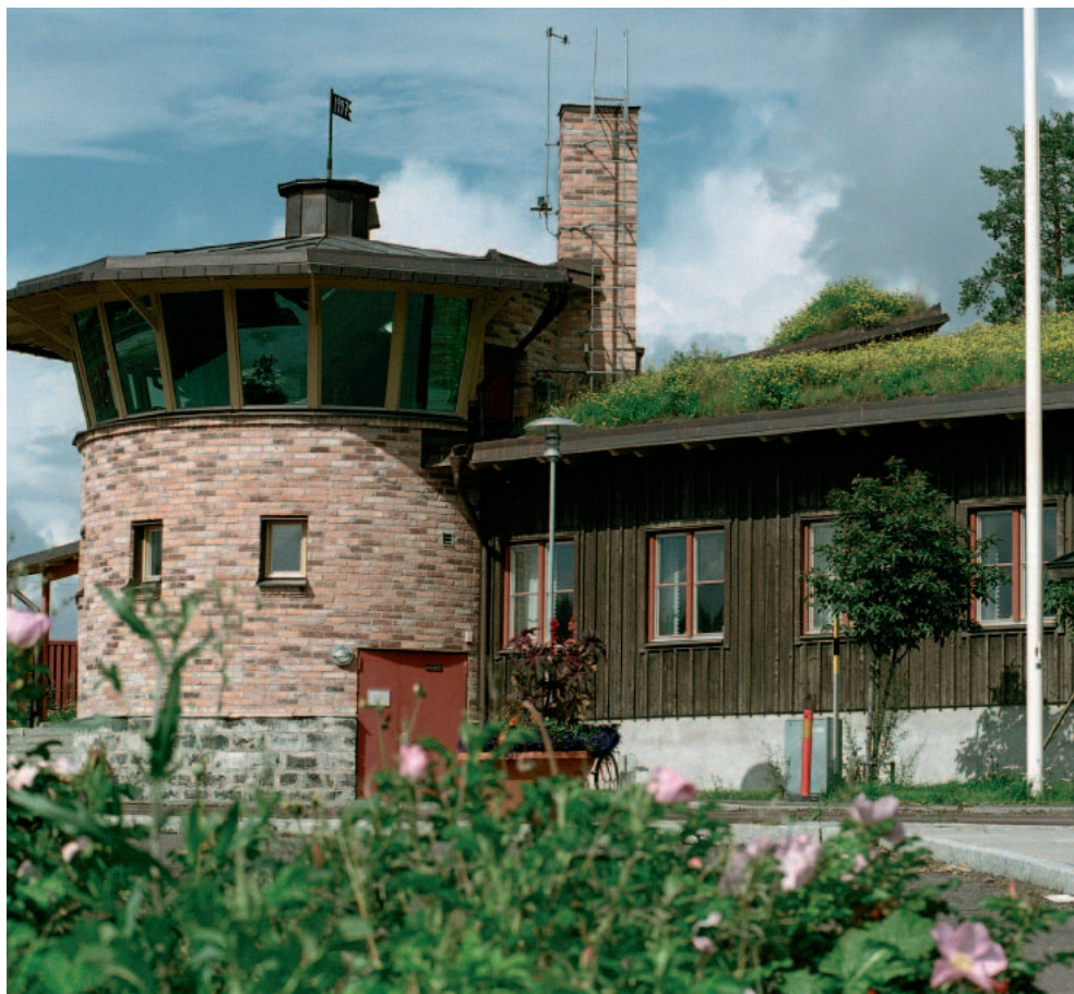
Vista del edificio de la empresa
