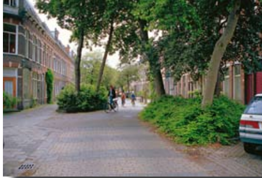
Groninga (Alemania) Pavimento continuo sin distinción entre calzada y acera. Área de coexistencia (Foto: Alfonso Sanz)
